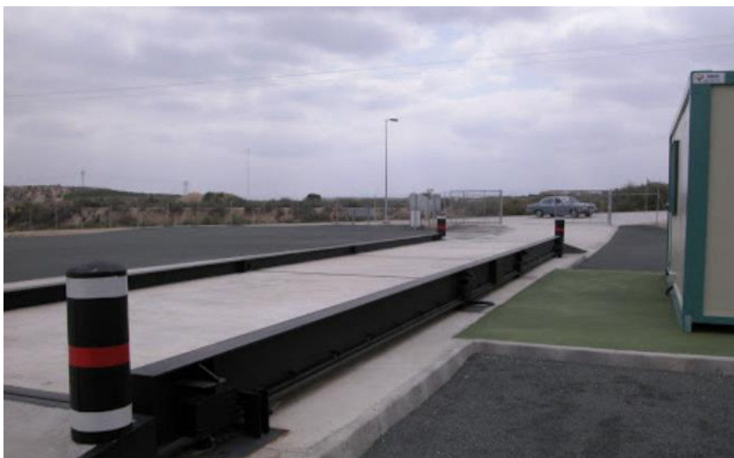
Ilustración 9. Báscula de pesaje de hormigón
