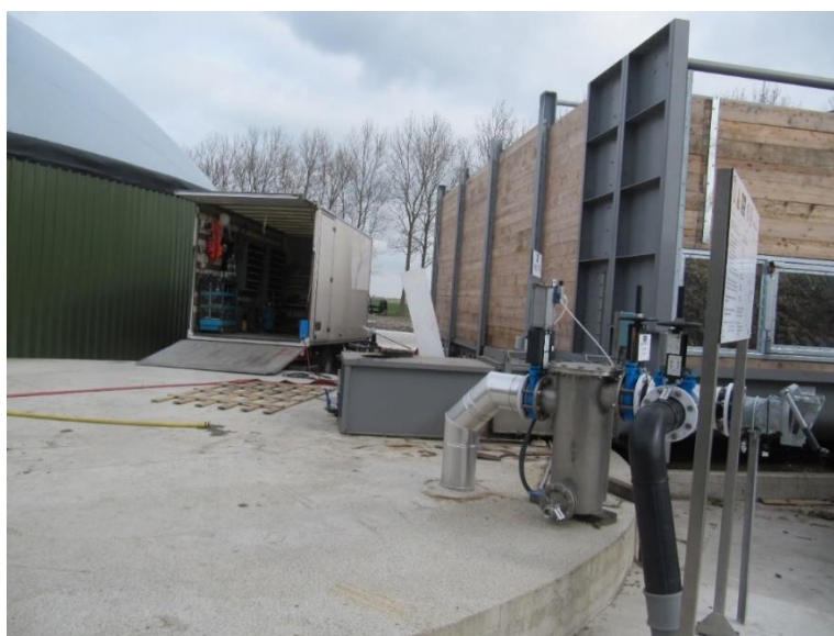
Ilustración 23. Toma para la descarga de camiones
