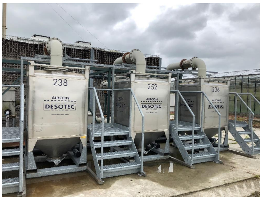
Ilustración 14. Filtros de carbón activo para la eliminación del azufre y siloxanos presentes en el biogás
